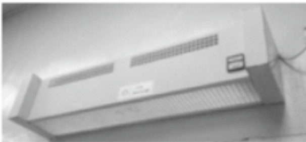
Gambar 2. UVGI dan HEPA filter pada kamar operasi yang selalu menyala selama pembedahan berlangsung.
